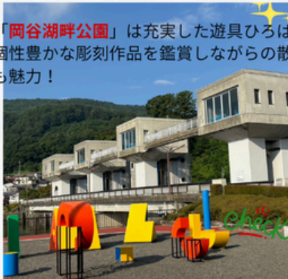
釜口水門とその周辺
